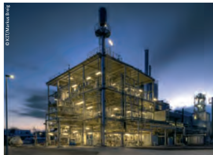
Am Karlsruher Institut für Technologie werden in einer Pilotanlage pflanzliche Reststoffe zu Synthesekraftstoff umgewandelt.
