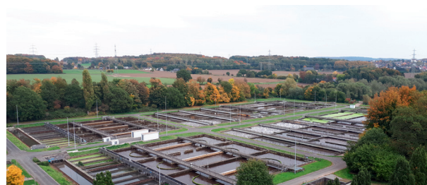
Die Kläranlage Ölbachtal in Bochum mit der Größenklasse 5 ist eine der beiden ausgewählten Versuchsanlagen im Projekt KAbit.
