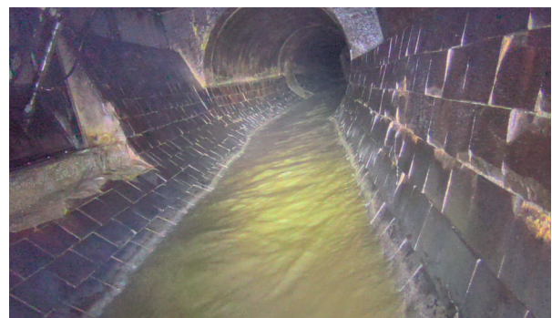
Ist-Situation in einem Abschnitt des Jenaer Kanalnetzes
