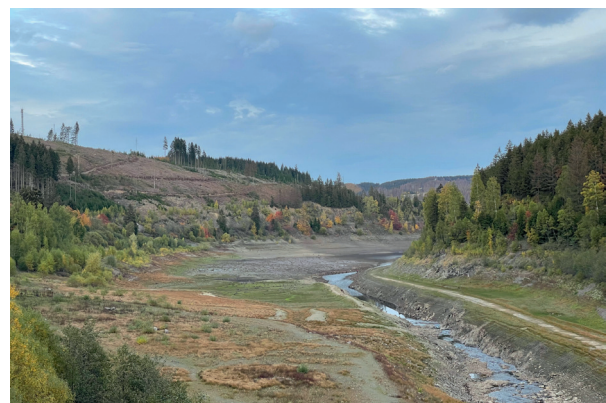
Die Okertalsperre im Harz im Oktober 2022: Anhaltende Trockenheit führt zu niedrigem Wasserstand und Baumsterben, was wiederum die Böden anfälliger und weniger aufnahmefähig für Niederschläge macht.
