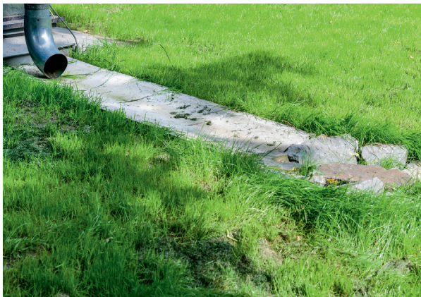
Regenwasserabkopplung und Versickerung im urbanen Raum
