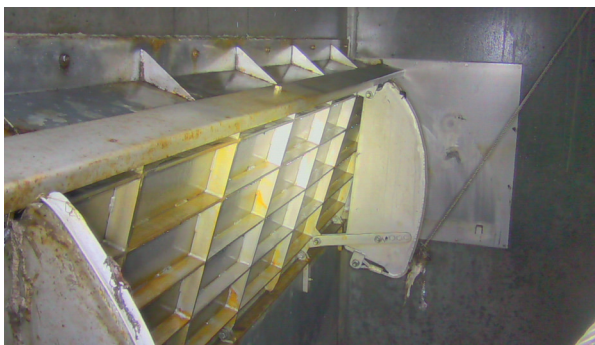
Beispiel einer Absperrarmatur
