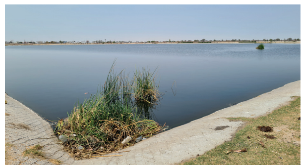
Abwasserteich in Oshakati – ein typisches Beispiel für viele Kommunen in Namibia. Die Teiche sind häufig zu klein dimensioniert, sodass sie während der Regenzeit oft überlaufen.
