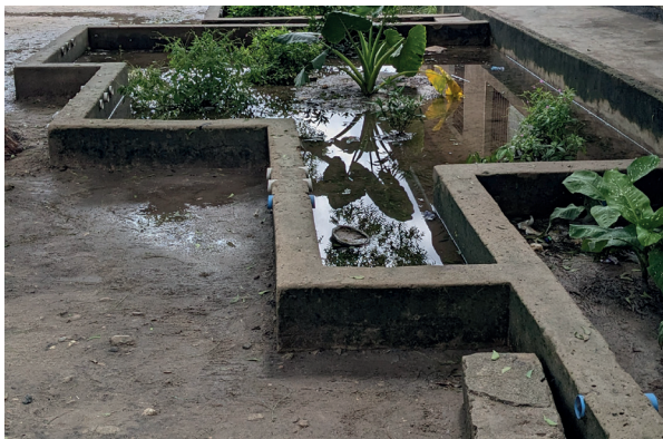
An der Mburahati Secondary School in Dar es Salaam, Tansania, werden Pflanzenfilter erprobt.
