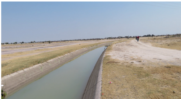
Überleitungskanal vom Cunene in das Cuvelai Einzugsgebiet in Nordnamibia
