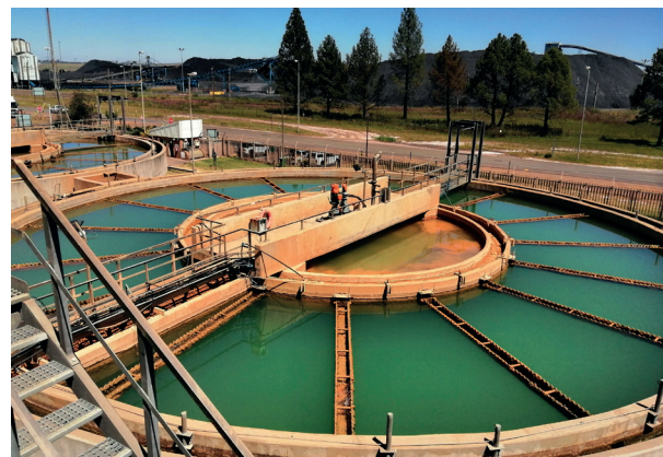
Grubenwasser wird zur Aufbereitung in ein Absetzbecken geleitet.
